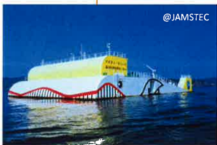
沖合浮力式波力装置「マエティーホエール」
